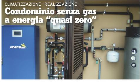
Pompe di calore reversibili, pavimenti radianti, elevata coibentazione e impianto fotovoltaico: così a Roma sono state realizzate 24 unità abitative autonome in classe A 4+. **pag 24**
